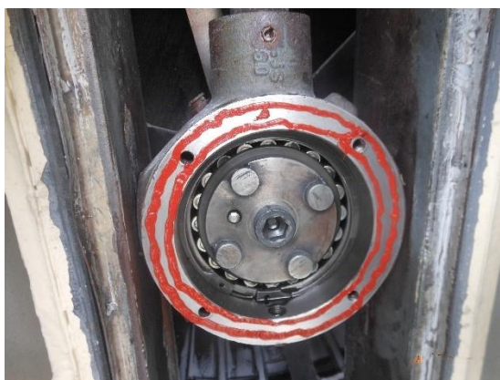
Servis velikega elevatorja - potem
