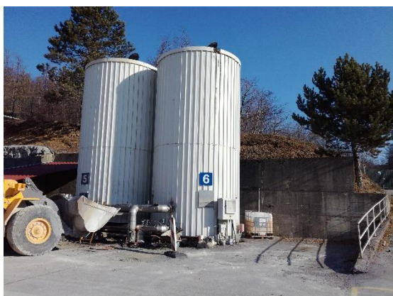
Remont – silos asfaltne baze
