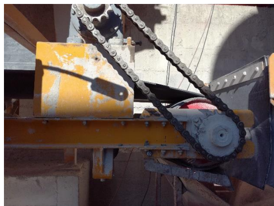
Remont – pogonski sklop
